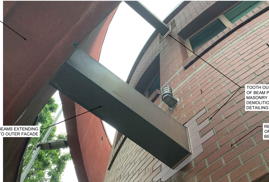
3 EXISTING WALL AT BEAM - PHOTO A5.200 SCALE: N.T.S.
